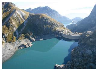
Données : La centrale Nant de Dranse est une installation de pompage - turbinage. La **dénivellation entre le bassin inférieur et supérieur vaut environ 425 mètres.**
